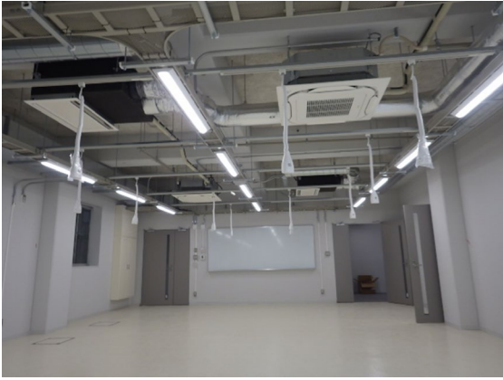
1C棟改修によるLED照明の設置
