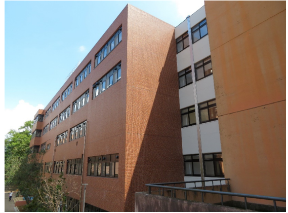
人間系学系 B 棟複層ガラスの設置
