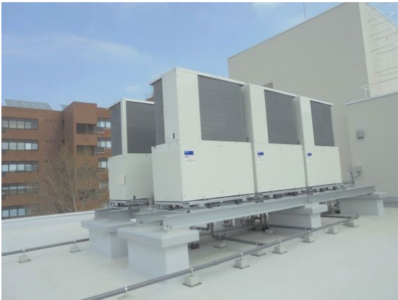
1C棟個別方式空調機の設置
