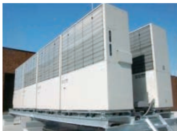
人文社会学系学系棟ガスヒートポンプ式空調室外機
