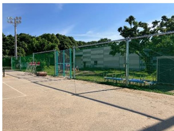
【南地区】ソフトテニスコート囲障改修工事
