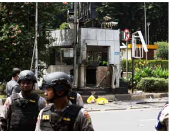
爆破された警察官詰所。武装した警察官が多数おり、物々しい雰囲気だった(1月14日、ジャカルタで)
