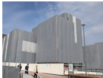
耐震改修工事中の1C棟(1月27日、第一エリアで) =車谷郁美撮影
