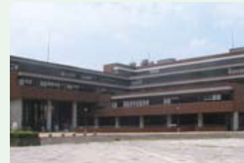
施設改修に伴う機器更新
