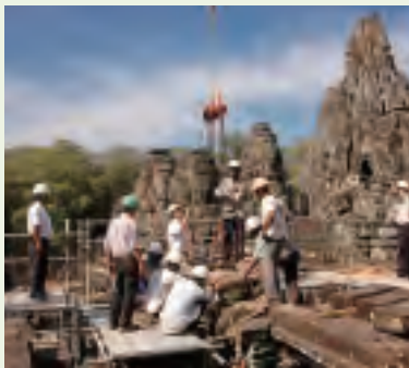
▲「バイヨン寺院」の修復工事 (写真提供: 日本国政府アンコール遺跡救済チーム)
