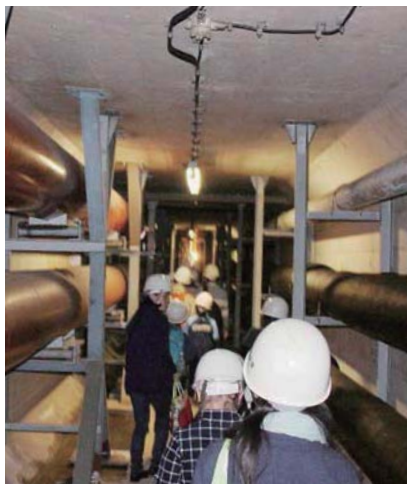
巨大な地下空間を探検した筑波大学地底探検ツアー
