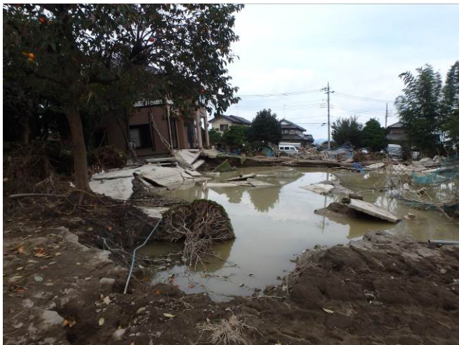
図-5 洗掘された民家の庭（若宮戸，9月17日）
