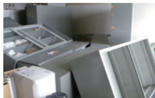
写真3 医学エリア研究棟8階の書庫転倒例 書棚の上下連結がなく転倒防止器具は設置していたが間仕切りとして使用していたため激しく転倒した
