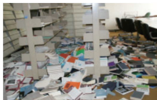
写真4 第三エリア研究棟12階図書室 上部を連結し脚を固定した書棚の転倒は免れたが書籍が落下した
