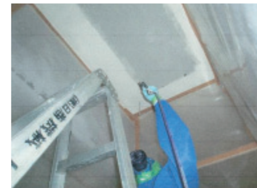
アスベスト除去作業
