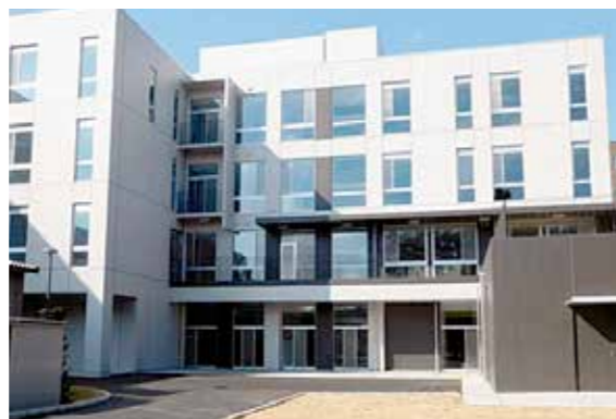
グローバルスポーツインベーション棟複層ガラス(二重)窓の設置
