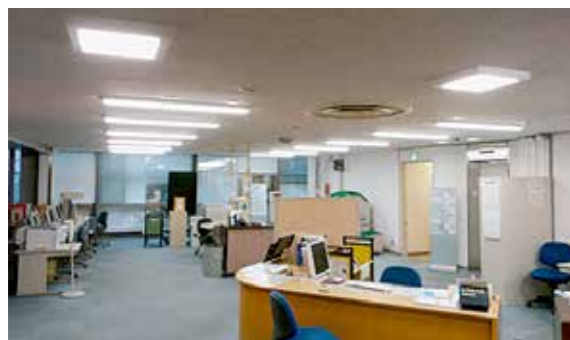
体芸図書館照明改修による LED 照明の設置
