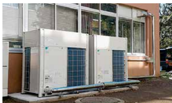
工学系学系 G 棟に個別方式空調機の設置
